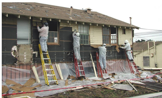
Εικόνα 6: Διαχωρισμός ξύλινων μελών κατοικιών -προ της κατεδάφισής τους- με σκοπό την επαναχρησιμοποίηση (Auburn Machinery 2003).
