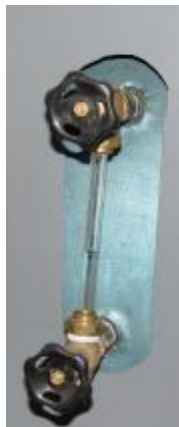
Εικόνα 25: Ο δείκτης στάθμης νερού της ατμοπαραγωγού μονάδας
